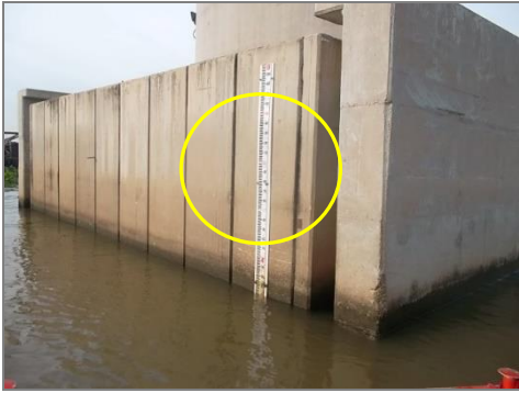
ภาพที่ 2.2-18 บรรทัดน้ำบริเวณต่อม่อสะพานรถไฟฟ้
