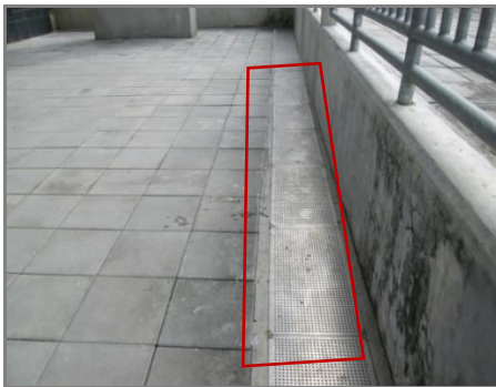
ภาพที่ 2.2-23 ระบบระบายน้ำบริเวณสถานีรถไฟฟ้า
